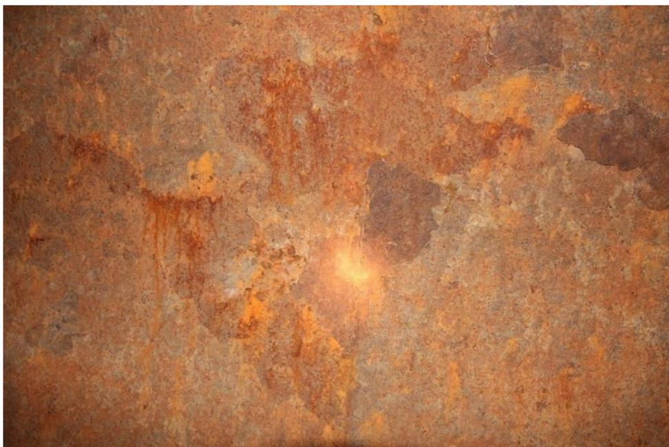
Рисунок 7 - Ржавые потеки в местах избыточных напряжений
