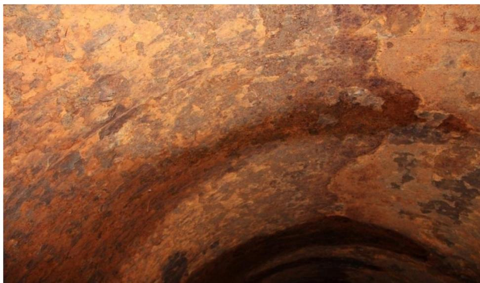
Рисунок 8 - Ржавые потеки в местах образования избыточных напряжений
